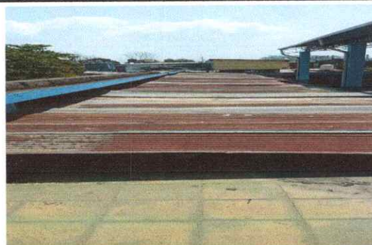
Foto 4: Sustitución de lámina por lámina troquelada calibre 26
