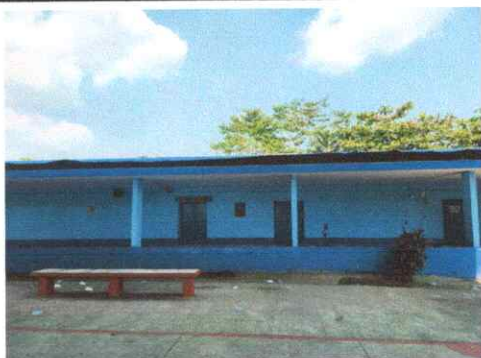
Foto1: Sustitución de lámina por lámina troquelada calibre 26
