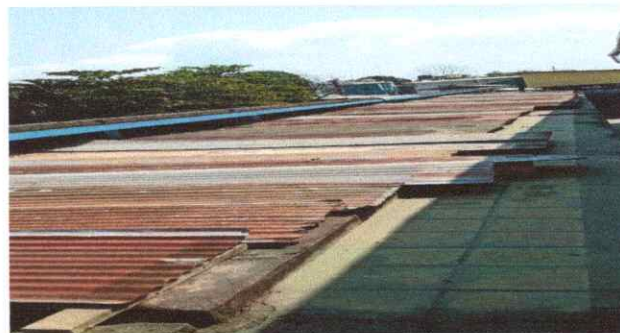
Foto 2: Sustitución de lámina por lámina troquelada calibre 26
