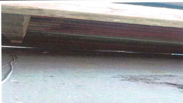
Foto 3: Sustitución de lámina por lámina troquelada calibre 26
