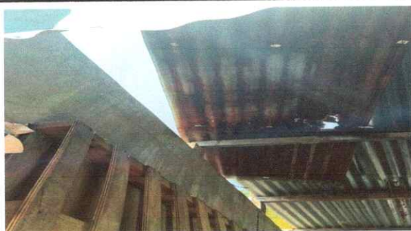
Foto 5: Sustitución de lámina por lámina troquelada calibre 26
