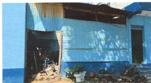
Foto 6: Sustitución de lámina por block
